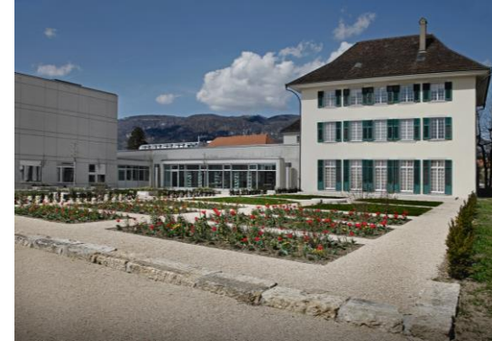
Zentralbibliothek Solothurn Neubau Zentrallager, Minergie-Standard
