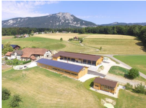
Bildungszentrum Wallierhof Riedholz Sanierung Gebäudehülle mit Holzbaulemente Minergie-Standard
