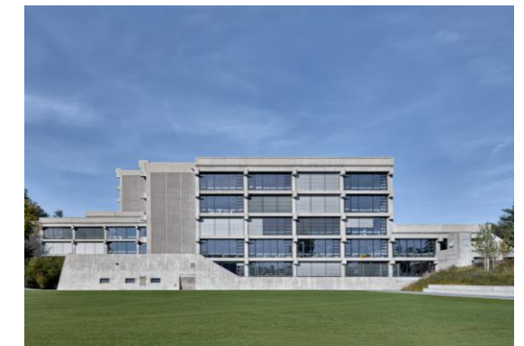
Kantonsschule Olten Neubau, Minergie-Standard
