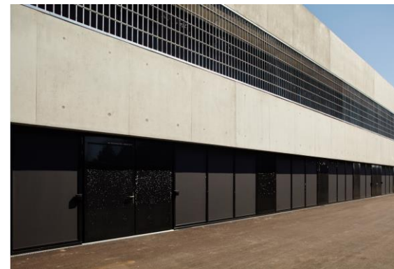
Justizvollzugsanstalt Flumenthal Neubau, Minergie-Standard
