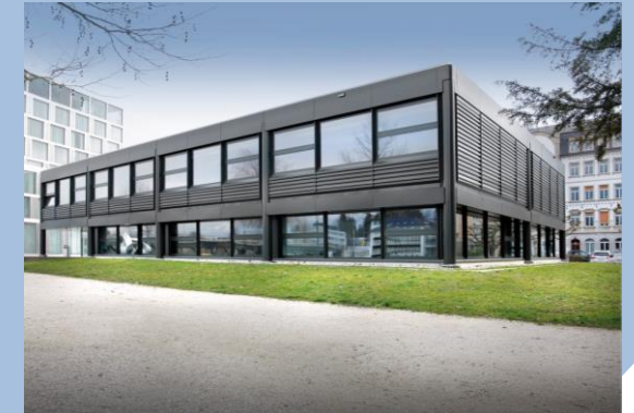
Berufsbildungszentrum Solothurn Sanierung Pavillon, Minergie-Standard
